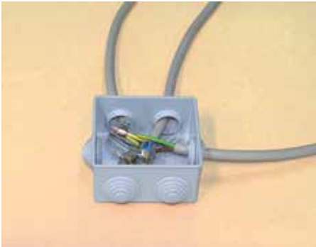
Cablare i cavi nella scatola di derivazione
